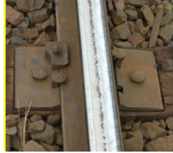
Mild Spalling
